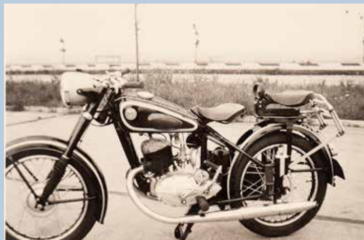
KR 25 HM (Foto oben und unten) in schwarzer Lackierung mit Jurisch-Hinterradfederung.
