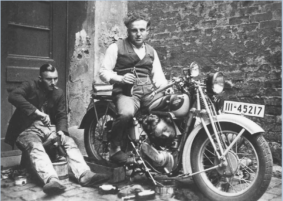
Hinterhof-Reparaturarbeiten mit Kolbenbesichtigung, Zylinder entkohlten und Einschleifen der Ventile.
